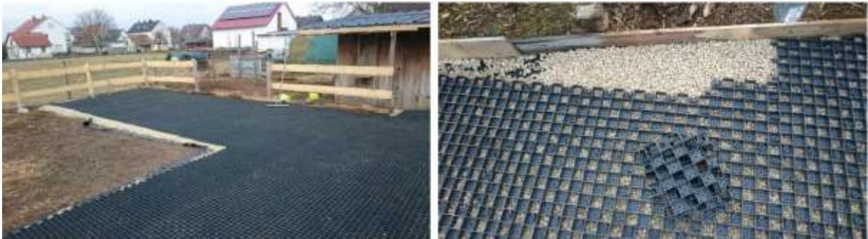
Anschliessend alles mit der Rüttelplatte abrütteln. Die Quadrate füllen sich zu ca. 30 % und die Fläche wird dadurch ebener!
